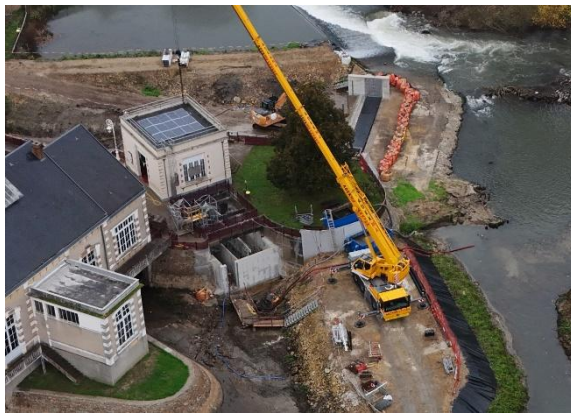
Création d'une passe à poissons au barrage de l'Epau
